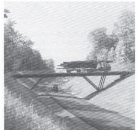
Bild 8 Einspur-Strassenbrücke (Brückenklasse 30) über die B 295 in Stuttgart
