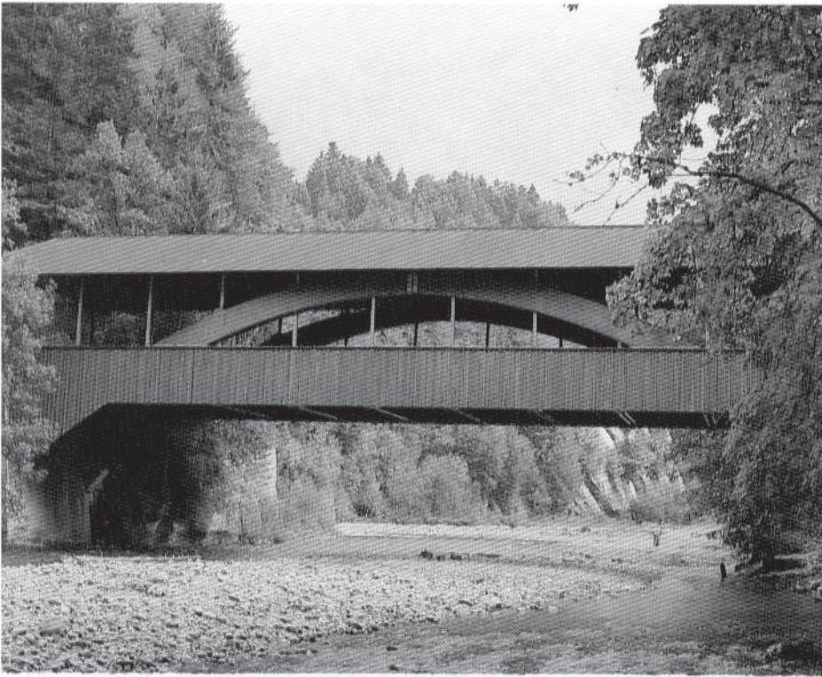
Bild 18 Straßenbrücke über die Sense bei Ablingen, Schweiz 1977
