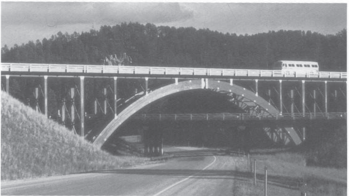
Bild 10 Autobahnbrücke bei Mount Rushmore in South Dakota, USA 1968
