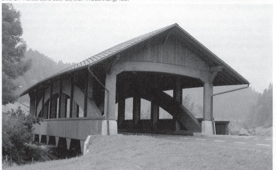
Bild 25 Straßenbrücke f. ca. 60 t Nutzlast in Eggwil, Schweiz 1984
