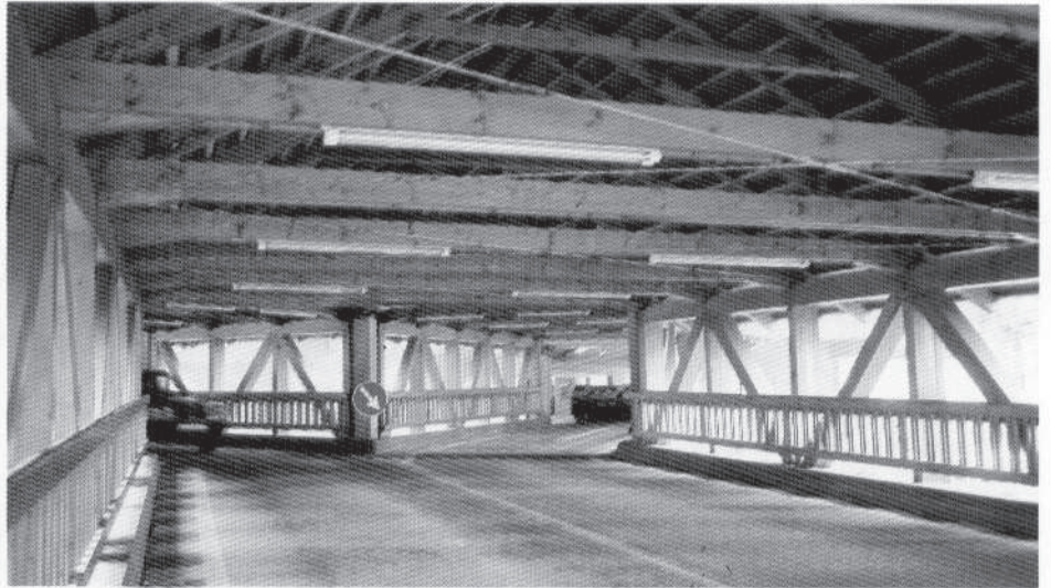
Bild 24 Autobrücke über die Murr in Backnang, 1987
